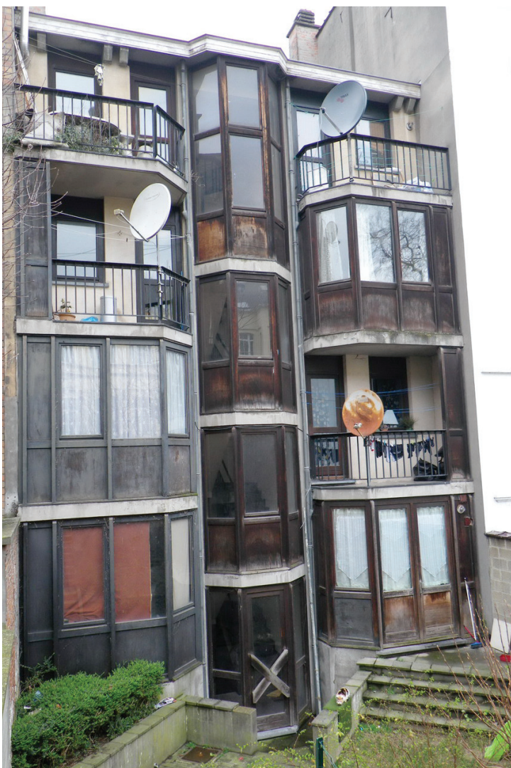
Avant rénovation des châssis
