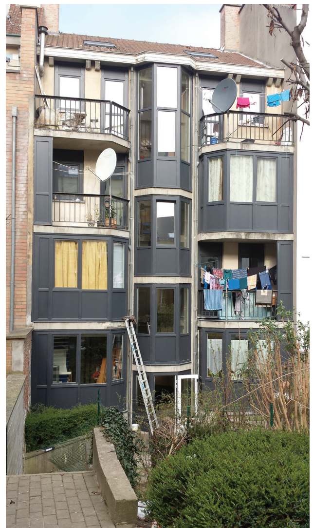
Après rénovation des châssis
