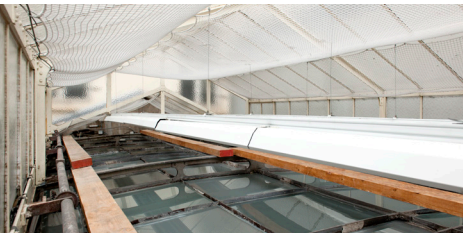
Structure interne de la verrière droite surplombant le jardin d'hiver Photographie Philippe De Gobert / AAM @2012, SOFAM, Belgique
