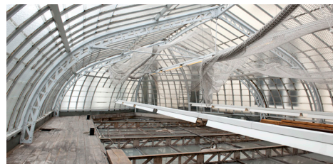
Structure interne de la verrière galbée surplombant la salle de concert Photographie Philippe De Gobert / AAM @2012, SOFAM, Belgique
